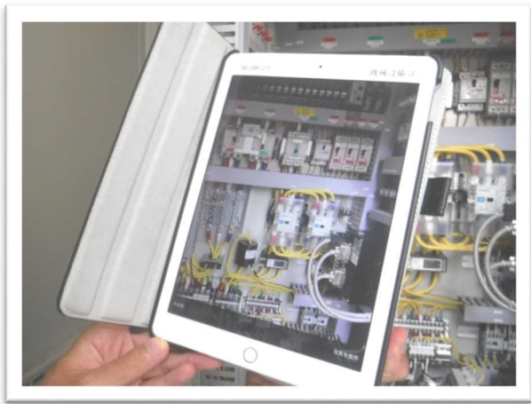
写真-5 現地での写真撮影状況
