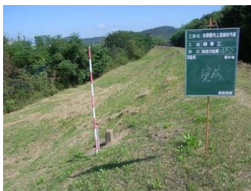
図-3 刈り放し後の堤防法面
