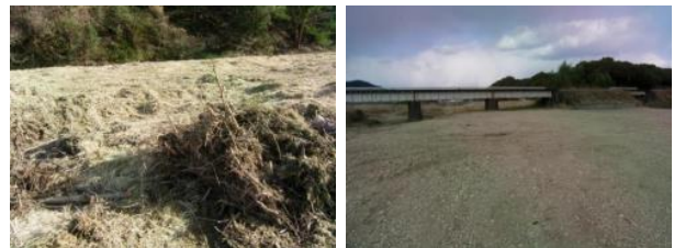
図-12 施工状況 (左: 掻き起こした地下茎 右: 施工直後)
