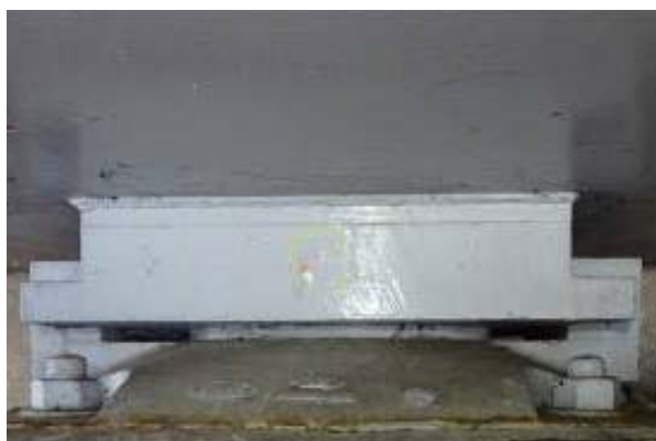
写真-8 支承の状況写真、傾きやセットボルト緩みなし
