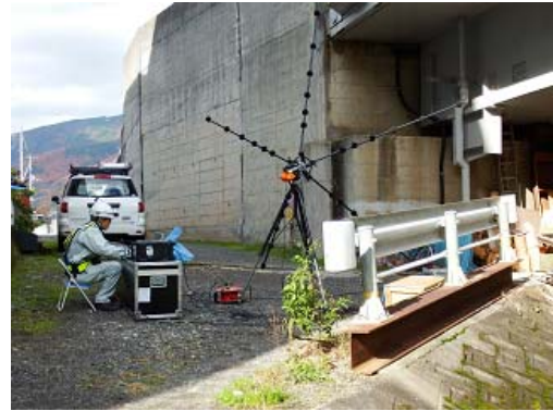
写真-2 ビームフォーミングによる調査状況
