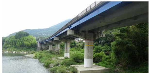
写真-1 全景 A2から起点側を望む
