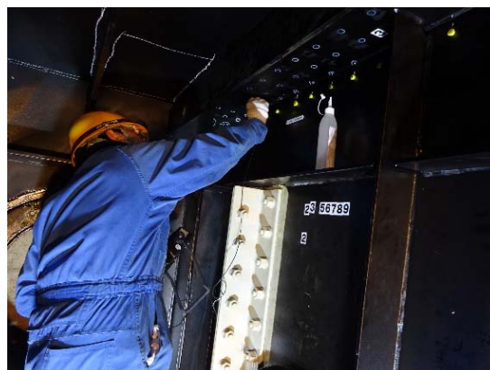
写真-3 超音波探傷試験による調査状況
