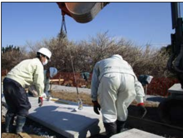
図-8 ブロック据付状況(吊り上げ)
