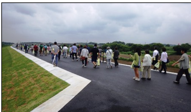
図-6 堤防用法肩ブロック 施工後写真
