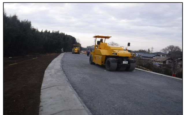
図-7 試験施工状況（路盤工）
