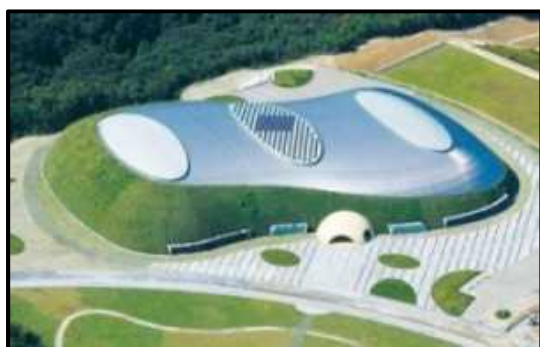
図-1 ビーンズドーム外観
