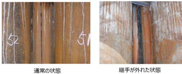
図-15 継手の変状
