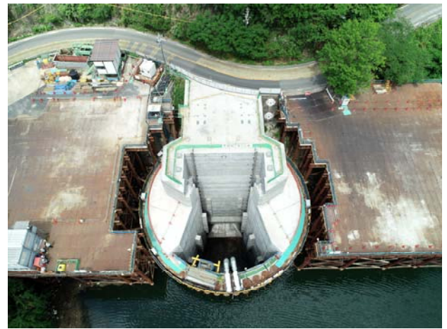
図-5 流入部の施工状況（2019年6月）
