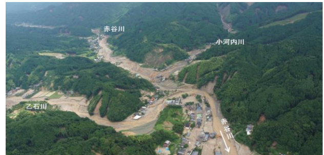
図-1 平成29年7月九州北部豪雨 河川氾濫の様子
