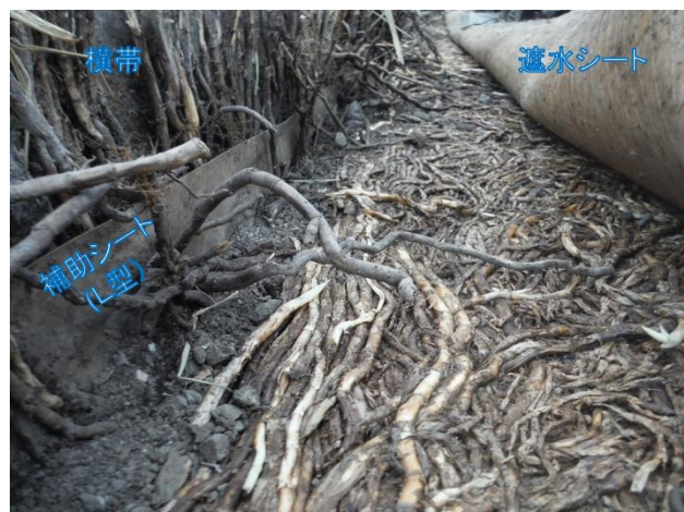
図-7 遮水シートと横帯の接着部(上方向を望む)
