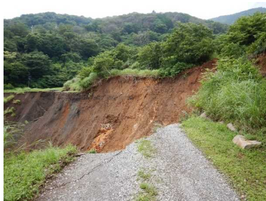
図-2 土石流源頭部
