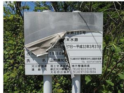
▲占用許可標示板の損傷
