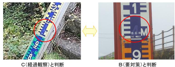
図-2 量水標の標記ラベル剥がれに対する判断のバラツキ
