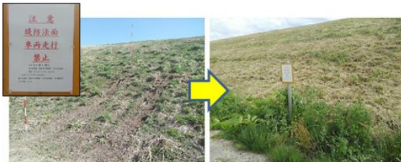
▲堤防の車両走行跡・轍掘れ(堤防に損傷無し) ※植生が回復したら終了
