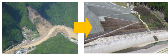
図ー4 完成した清水地区（奈良県五條市）
