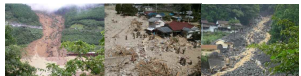
図-2 災害発生状況
