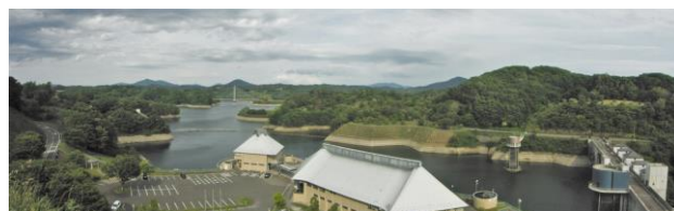
図-1 三春ダム全景（福島県）
