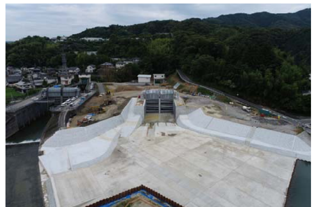
写真-2 新日下川放水路呑口の状況（令和5年6月時点）
