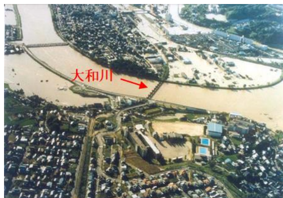
写真-1 昭和57年8月洪水浸水状況（王寺町付近）
