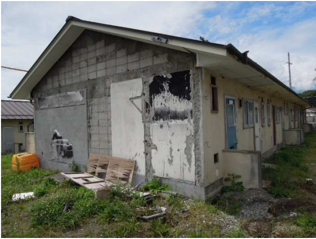
写真-1 解体する建築物の状況
