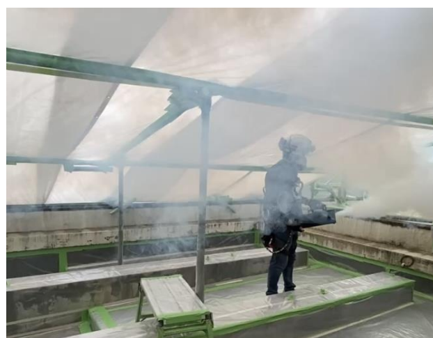
図5 スモークマシンを用いた負圧隔離養生の確認
