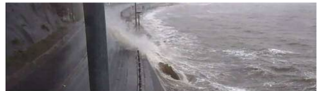
図-1 令和4年台風11号による越波状況
