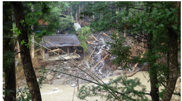
図-1 2017年7月九州北部豪雨によって 佐田川流域にて発生した土石流被害
