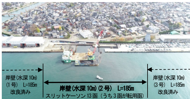
図-1 富山地区 岸壁(10m)(2号)改良
