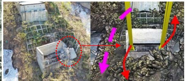
写真－6 P1橋脚の損傷状況
