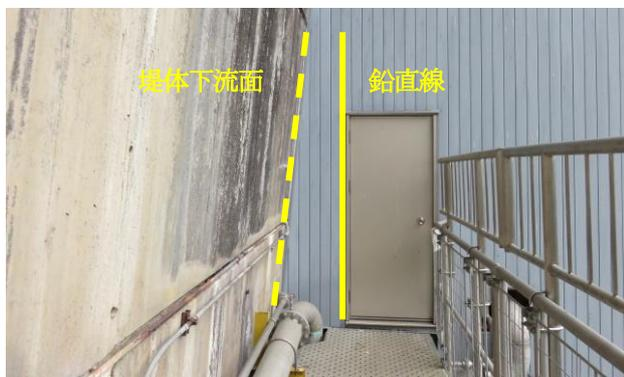
図3 ダム堤体の傾斜
