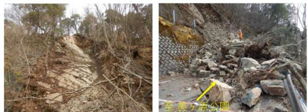
写真-2 斜面上部（左） 道路閉塞状況（右）
