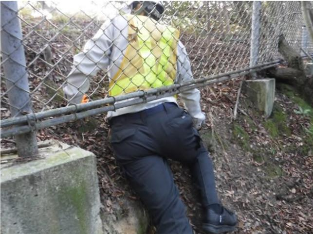
写真-3 立入防止柵下部の隙間
