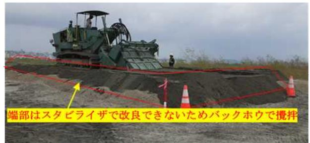
図-9 軽石改良端部処理
