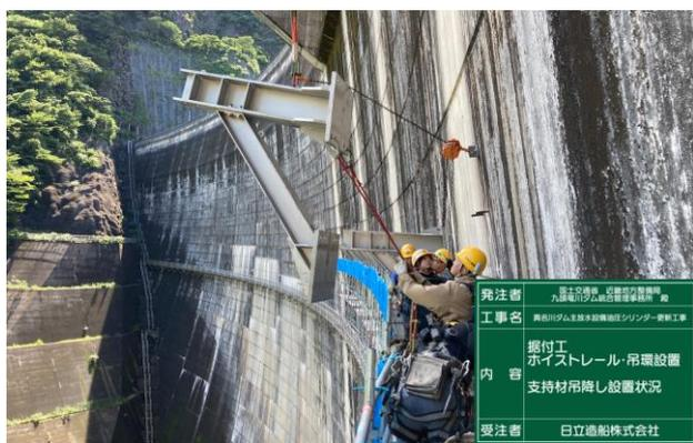
図-6 ホイストレール取付け状況
