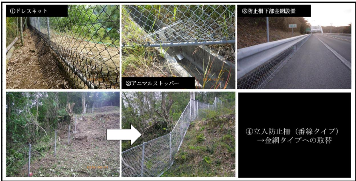
写真-2 高速道路本線への動物侵入対策事例
