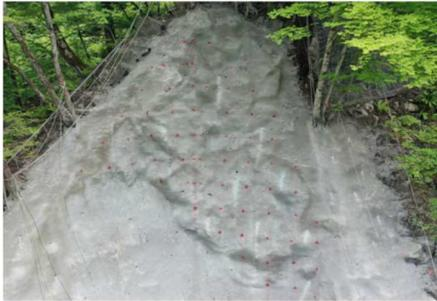
写真-4 鉄筋挿入位置の墨出し
