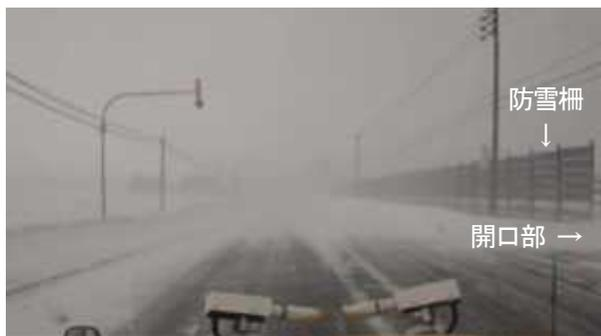
写真-1 防雪柵の開口部における吹雪時の状況の例<sup>2)</sup>。
