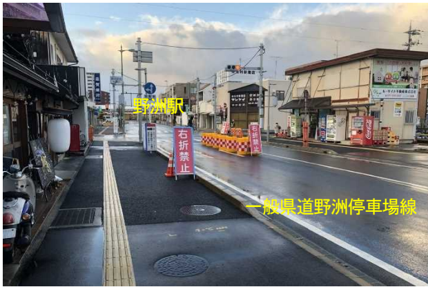
写真-9 クッションドラム設置状況
