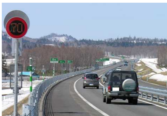
写真-2 道路付属物等の設置状況
