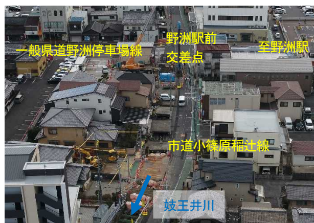
写真-3 Ⅱ期工事施工状況
