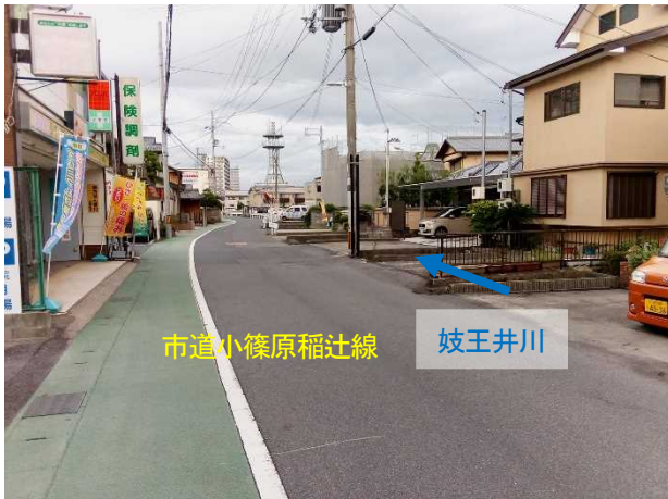
写真4 II期工事の現場状況
