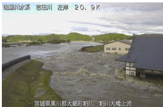
図-1 東日本台風 被災状況
