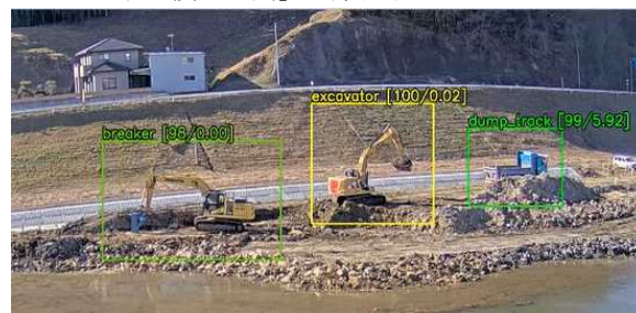
図-4 重機稼働状況モニタリング画像
