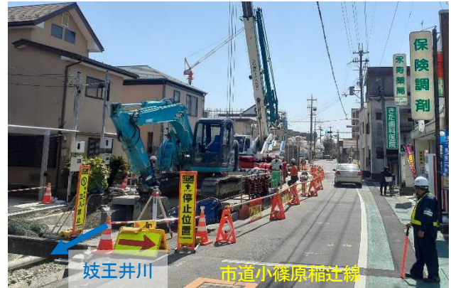
写真-10 施工状況
