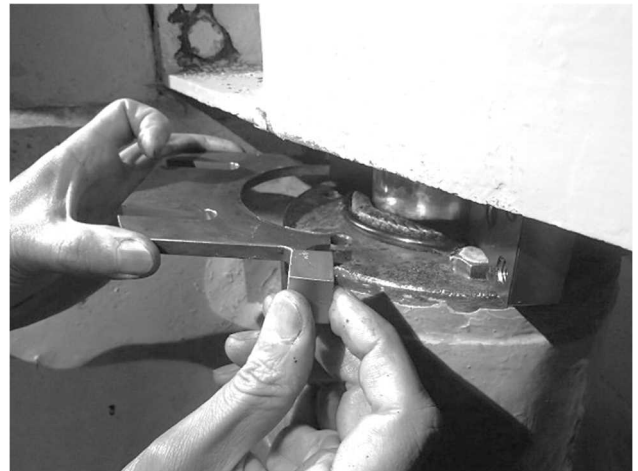
写真-4 装置の設置の様子
