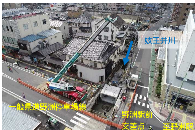
写真-2 Ⅰ期工事施工状況
