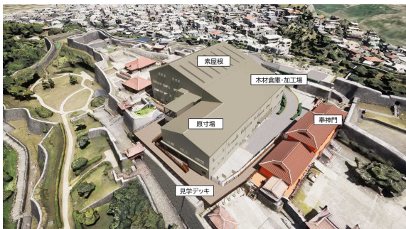
図1 正殿周辺の工事建屋等
