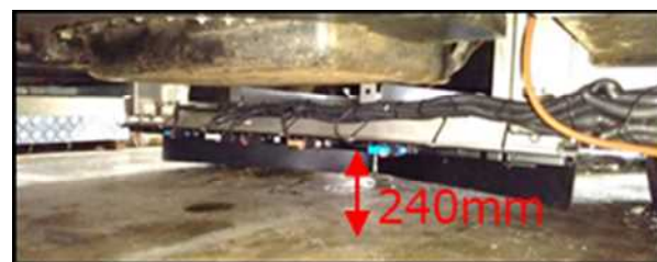
写真-1 車両側のアンテナ設置状況
