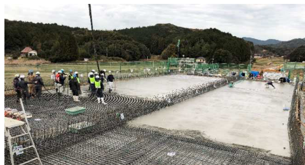
写真-3 工事全景
