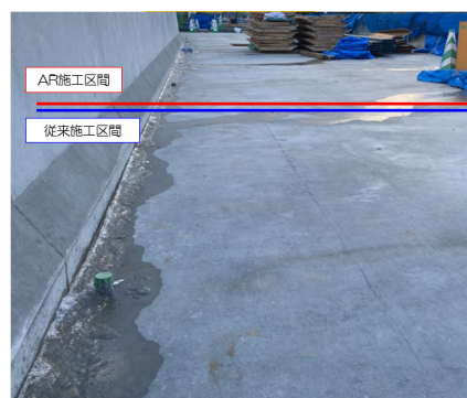
写真7 仕上がり写真
