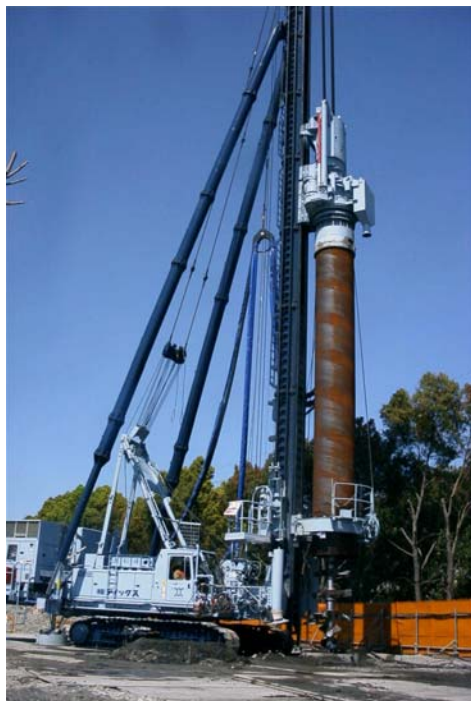
写真 - 2 ガンテツパイルの施工状況 (同時沈設方式)
