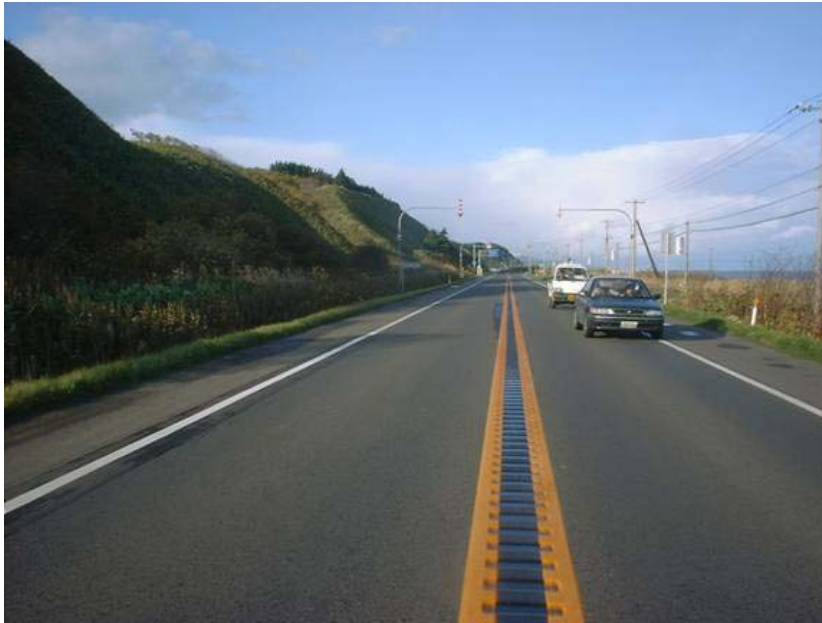
写真 1 ランブルストリップス設置・供用状況
