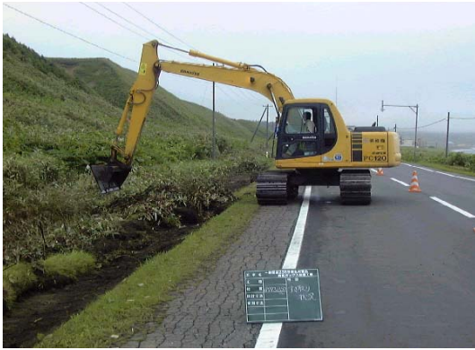
写真 1 草根すきとり状況
