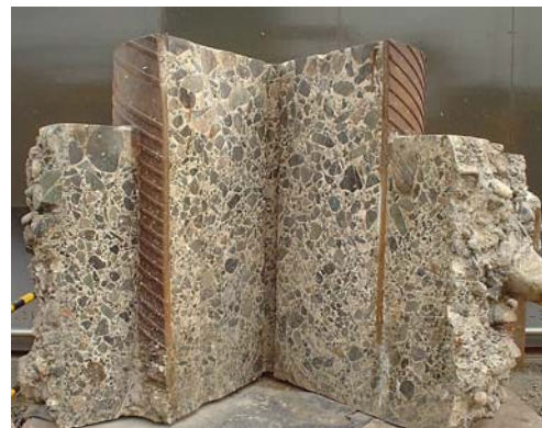
写真 - 3 ガンテツパイルの先端部の造成状況 (現場造成杭を掘り起こし後に切断し断面を撮影)
