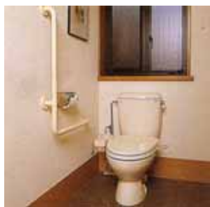
手すりの設置
