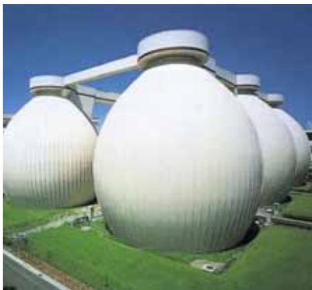
汚泥の利用 < 汚泥消化ガス > (横浜市)
