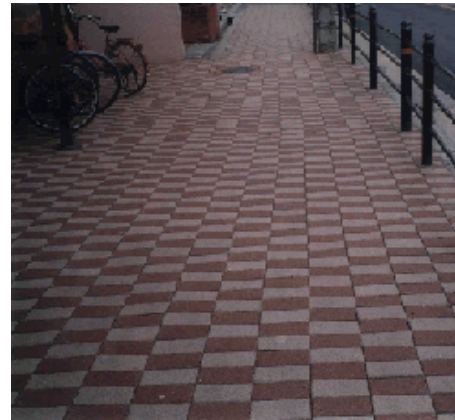
汚泥の利用 < レンガ > (大阪市)
