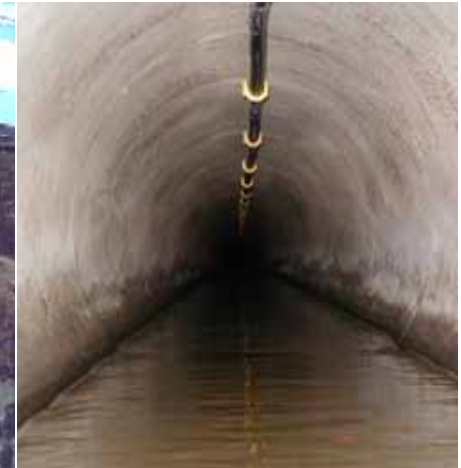
下水道管きょ内の光ファイバー敷設状況 (東京都)
