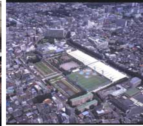
下水処理場の上部利用 (東京都)
