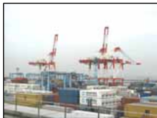
荷役機械の高度化による作業効率化
