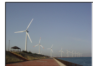
港湾空間における風力発電
