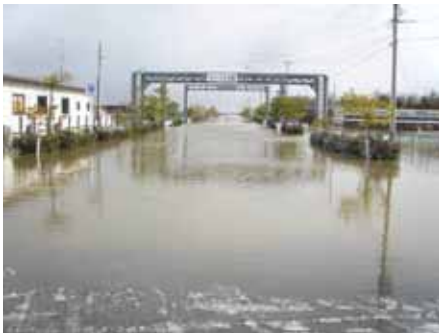
伏木地区万葉ふ頭緑地臨港道路万葉1号線波浪により冠水
