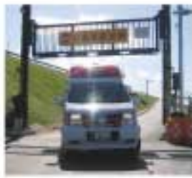
救急医療を支える高速道路の緊急出入口
