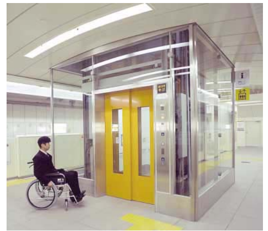
エレベーター
