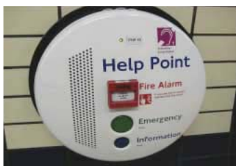
写真6 欧州で普及しているヘルプ・ポイント
