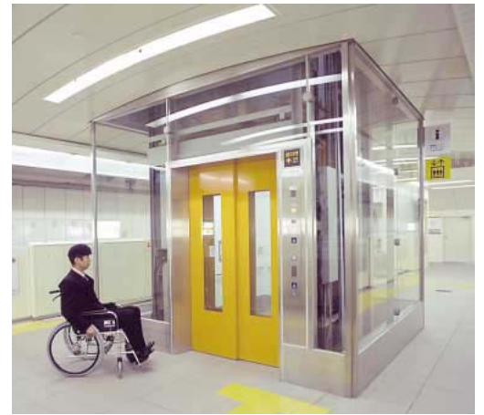
エレベーター
