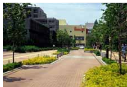
図5-2-4 (11) クランクによる交通静穏化(北部拠点宮原地区)
