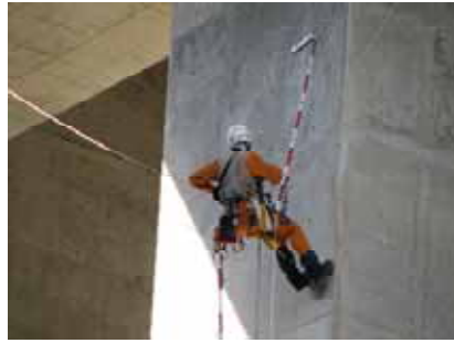
【橋脚のひびわれの発見】
