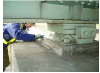
【沓座の腐食の発見】
