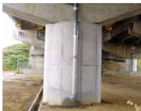
耐震対策が完了したため損傷が無かった例
