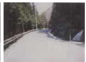
1車線 + 待避所設置
