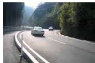
2車線 + 歩道整備
