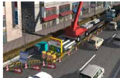
同時期に施工し工事日数を削減
