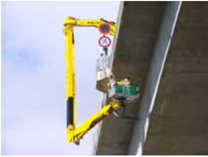
【橋梁点検車による定期点検】
