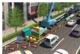
夏にガス工事を予定
