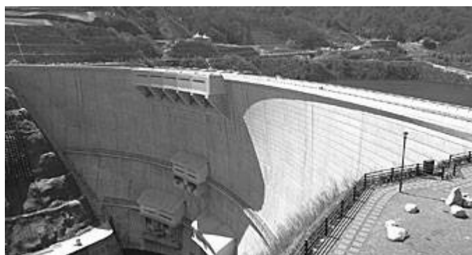
ぬくい 温井ダム
