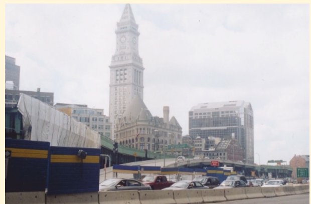
写真1 高速道路を取り壊し、地下化の工事風景（2003年）
