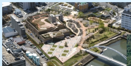
東品川屋上庭園(東京都品川区)
