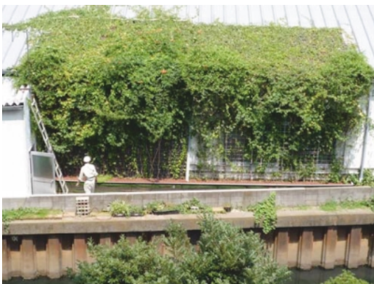
検証実験の様子（設置後1年5カ月経過）
