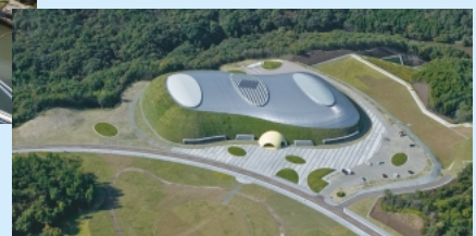
三木総合防災公園屋内テニスコートビーンズドーム(兵庫県三木市)
