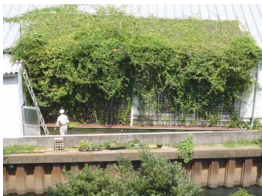
検証実験の様子（設置後1年5カ月経過）
