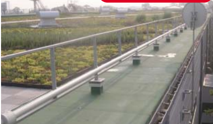
工場の屋上全体を大規模に薄層緑化し、地域の微気象環境保全にも寄与。工場立地法の適用による工場増設が動機。
