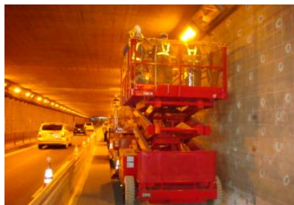
図-10 施工状況一例
