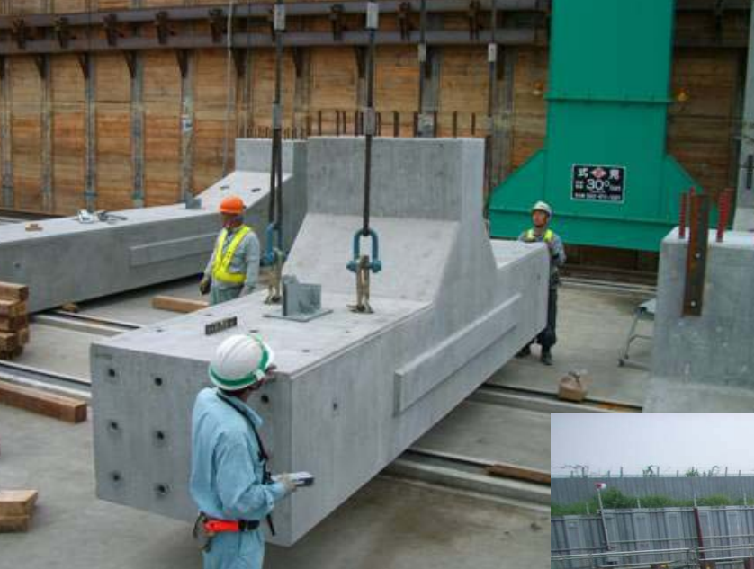
底版中央ブロック設置状況
