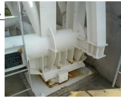
●腐食対策として満潮時に支承が海水に浸からないよう、**H.W.L.**に対して**30cm**以上を確保する。
