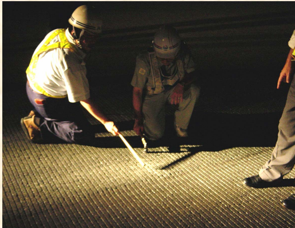
打音調査実施状況
