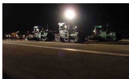
写真-6 工事の状況
