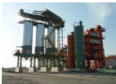
写真-5 空港内の仮設アスファルトプラント
