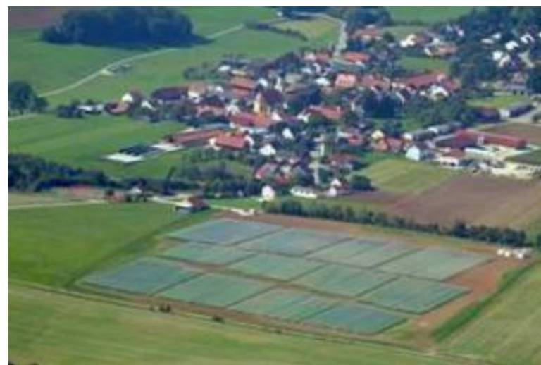
Günchingソーラーパーク : 1.9MW
