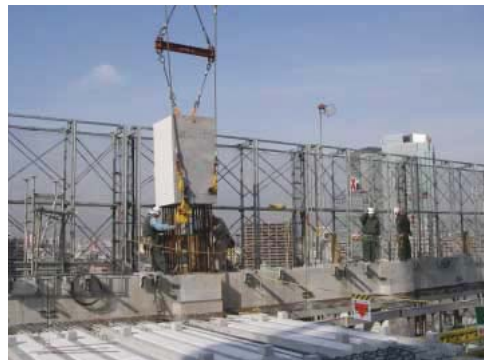
コンクリート部材から伸びる柱主筋をスリーブ継手に差し込んだジョイント
