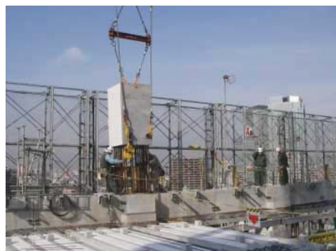
コンクリート部材から伸びる柱主筋をスリーブ継手に差し込んだジョイント
