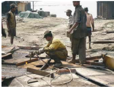
作業中の労働者。労働者は安全防具を付けておらず、裸足の場合もある。
