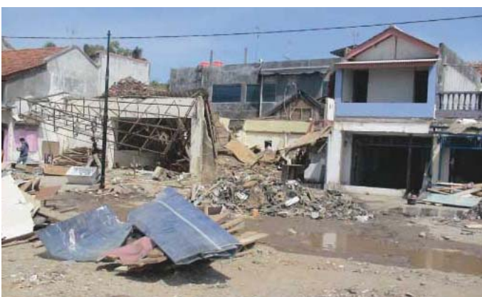
写真2 インドネシアジャワ島沖津波被害の様子 (2006年)
