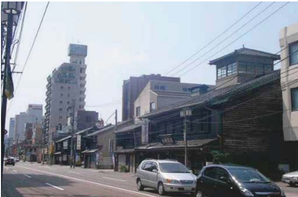
景観にそぐわない近代的なビルが建設され、歴史的風致が損なわれている
