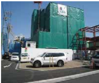
建設中の共同化住宅
