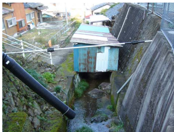
排水路の上に建てられた危険な小屋
