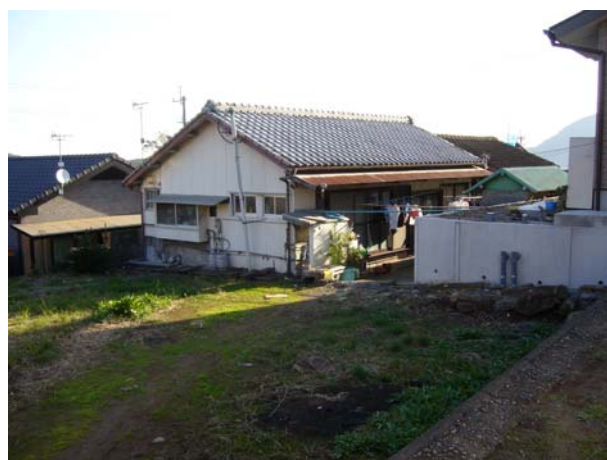
空き地と家屋に囲まれた未接道住宅
