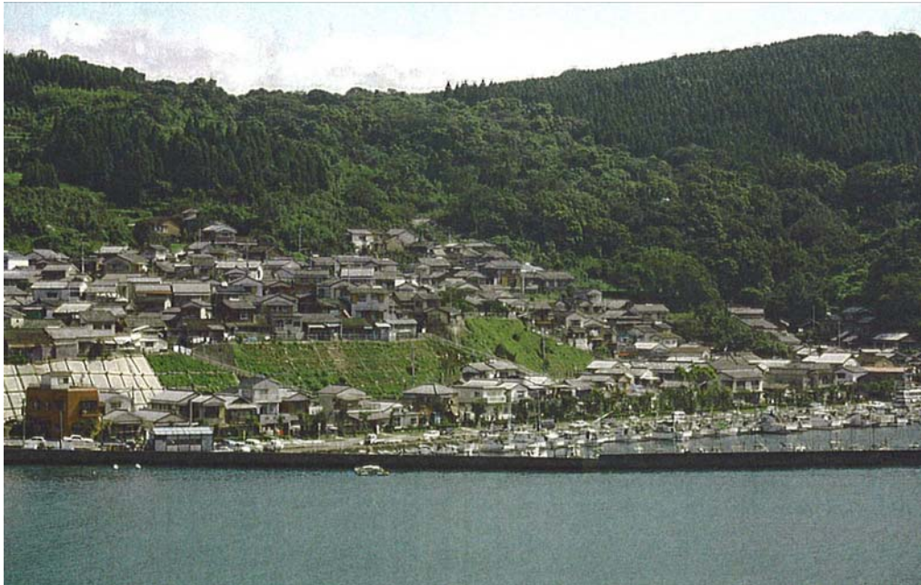
《地区の全景（対岸より）》
