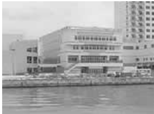
図 4-1-6 宮古島マリンターミナル 写真資料:平良港湾事務所
