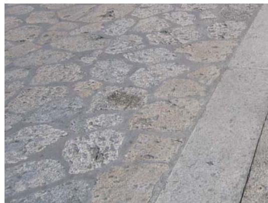
▲琉球石灰岩を用いた舗装
