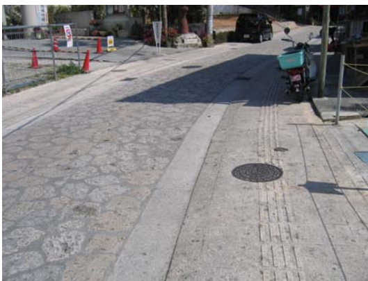
▲車道、歩道、側溝、点字ブロック
