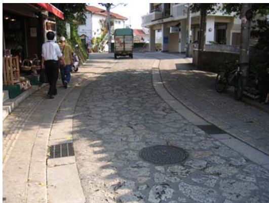
▲車いす利用者に配慮した歩道と車道の段差
