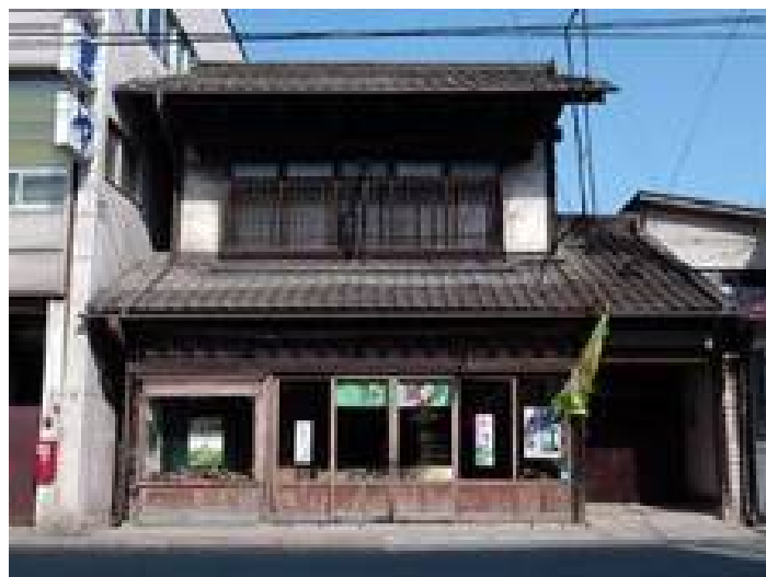
写－1 山形県山形市 平成18年に解体された繁田園茶舗
