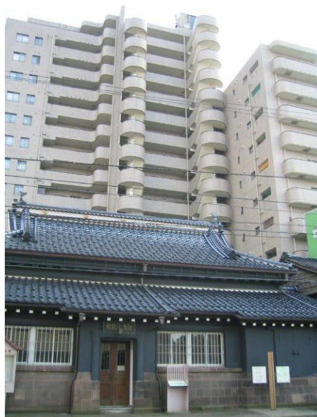
写－３ 石川県金沢市 県指定文化財の背後に建設された高層マンション
