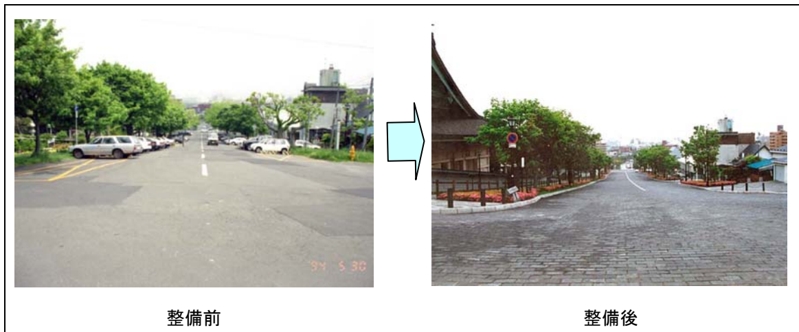
写－36 歴史的なまちなみにあわせた道路整備
