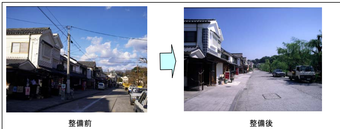
写－５９ 電線類の地中化とあわせて道路整備
