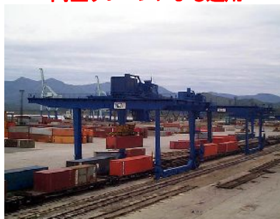
レールマウント式 門型クレーンによる運用
