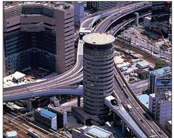
オフィスビルとの立体利用 阪神高速・梅田出路(大阪市)
