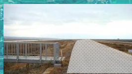
遊歩道・散策路の整備
