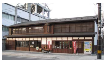
▲区画整理事業地内で曳き家保存した例
