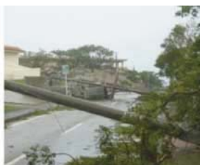
台風により電柱が倒壊
