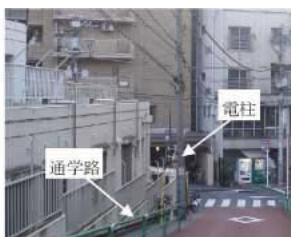
通学の支障となっている電柱
